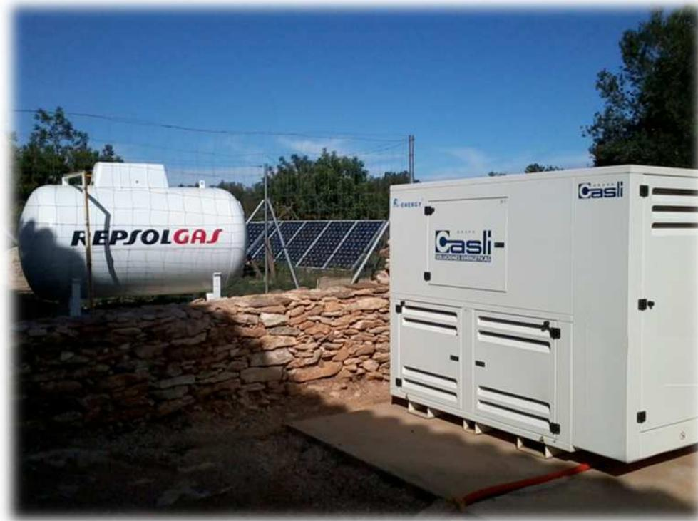
Obtiene la energía eléctrica de fuentes renovables como paneles solares fotovoltaicos o aerogeneradores combinada con la de un grupo electrógeno que puede ser Diesel o a gas propano, como respaldo del sistema.
