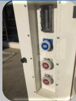
*Enchufes de conexión rápida con protecciones independientes*
